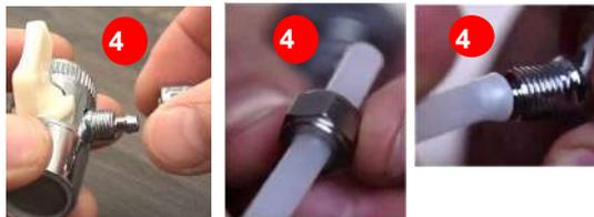
4. Überwurfmutter vom Umlenkperlator abschrauben und über passend gekürzten (Schere) ¼ Zoll Schlauch schieben. Diesen auf den Nippel aufstecken und Überwurfmutter festdrehen.
