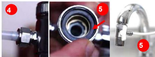
5. Nun den Umlenkperlator inkl. **Dichtung** auf dem Außengewinde festdrehen und mit Schlauch ausrichten, wie auf dem letzten Bild zu sehen.
