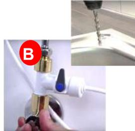
**2. Winkelabsperrventil (B) mit Bohrung:** Dabei erfolgt die Wasserzufuhr durch eine Abzweigung vom Kaltwasser-Eckventil.
